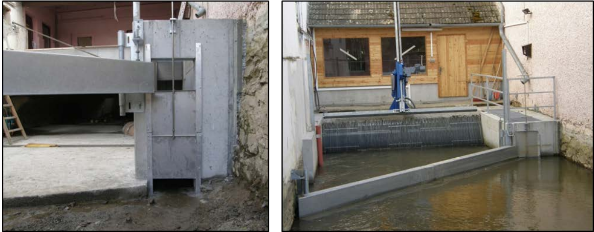
Abbildung 11: links: Leiteinrichtungen und Einstiegsöffnungen der Fischabstiegshilfe am Kraftwerk Riedmühle in trockenem Zustand. rechts: FAbH, Tauchwand und Feinrechen sowie Rechenreinigungsanlage im Regelbetrieb.
