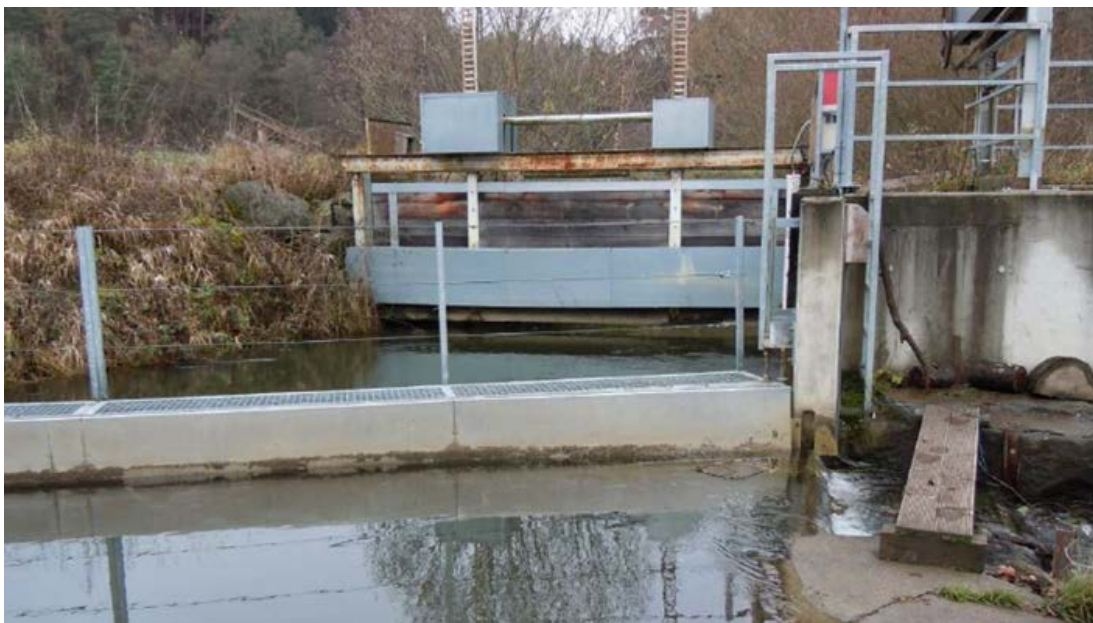
Abbildung 9: Tauchwand an der Wehranlage und daran anschließend der Dotationsschlitz für die Restwasserdotation. Dahinter: Dotationsbauwerk der FAH.
